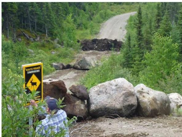
**Figure 11. Fermeture avec enrochements et tranchée**
