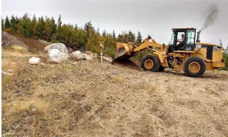
Figure 14. Fermeture 2016; enrochement et tranchée avec tractopelle
