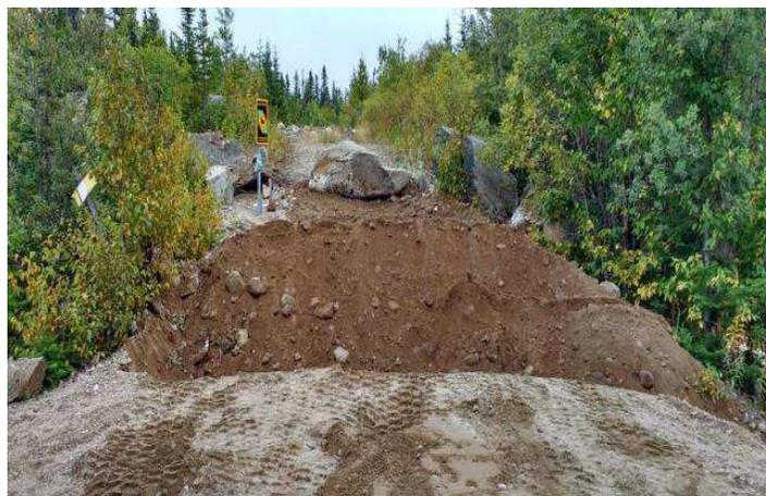
**Figure 13. Fermeture 2016; enrochement et tranchée**
